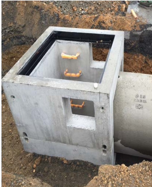
上下設置状況
